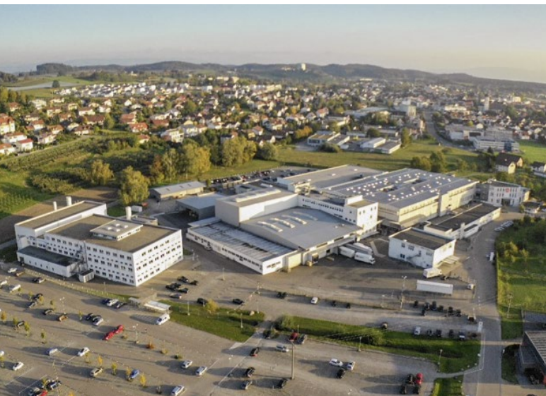
Auf dem ifm-Gelände wird wieder gebaut.
