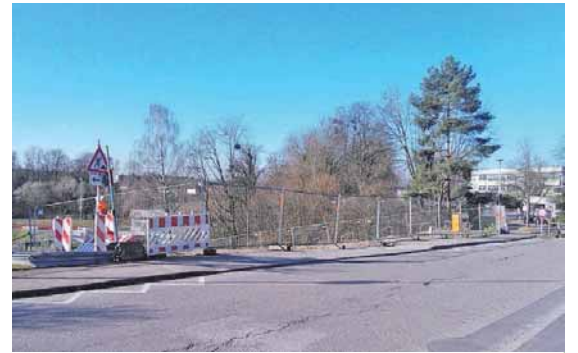
Manzenbergstraße 33, eine der drei Dauerbaustellen in Tettngang. Foto: Stadt Tettngang
