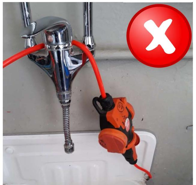
**Stromanschluss neben Wasseranschluss.**
